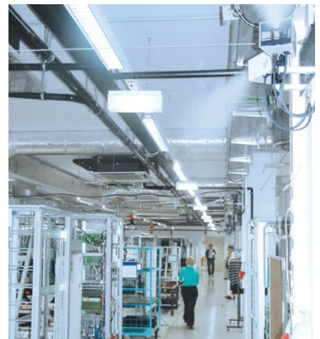
Die Luftbefeuchtung erzeugt bei Frequentis einen zusätzlichen Kühleffekt
